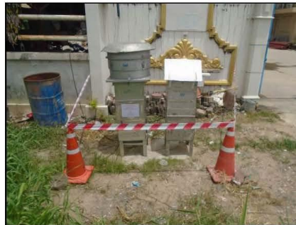
โรงงานผลิต GRC (พิกัด : 47P 0691685, UTM 1544061)
