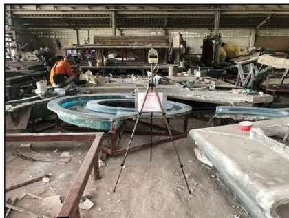
โรงงานผลิต GRC : บริเวณกลาง Line โรงผลิต
