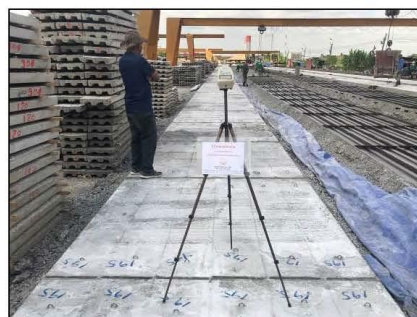
โรงงานผลิต Plank คลังสินค้า บริเวณท้าย Line ผลิต Zone 3
